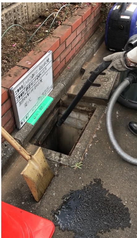
掻き出し後、洗浄清掃
